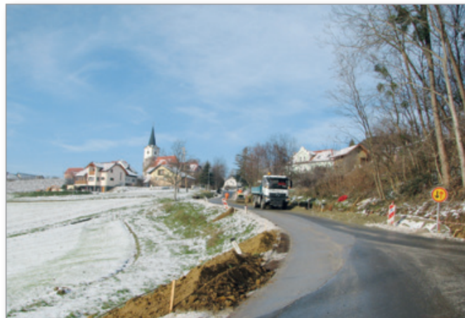
Dela izvaja Cestno podjetje Pomgrad Murska Sobota, vzdrževalna enota Lenart.
