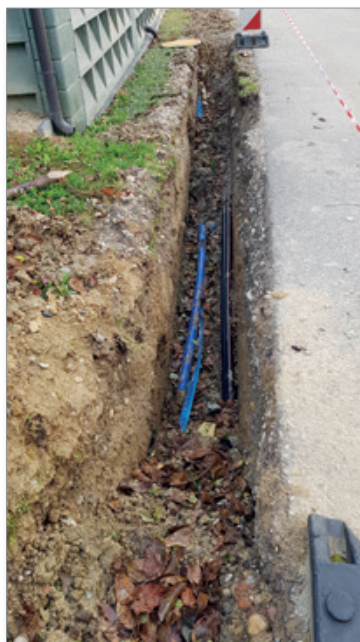
Gradnja vodovoda v naselju Župetinci
