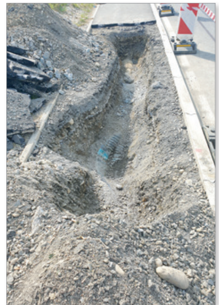
Stisnjena meteorna cev - vzrok za poškodbo ceste in luknjo na pločniku
