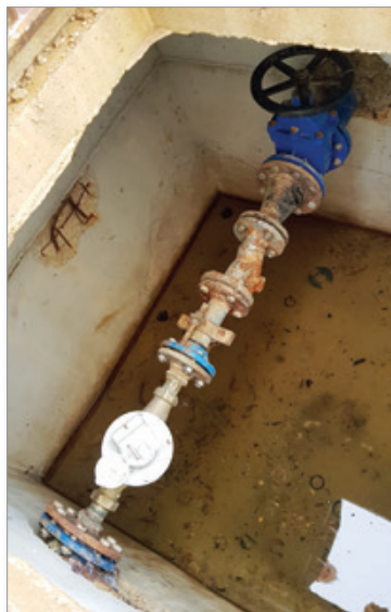
Točka, kjer se stikata stari in novi vodovod
